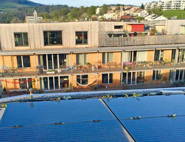
Blick vom Solardach auf die autofreie Siedlung Oberfeld.
