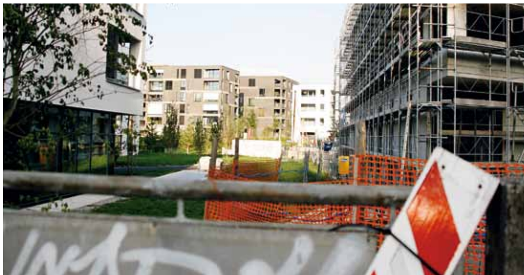
Grenzquartier: Baustelle und Wohnbauten zwischen Bern und Köniz.
